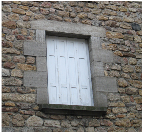
encadrement en béton interdit
