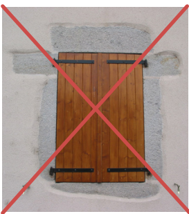
L'enduit est en surépaisseur de la pierre.
