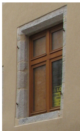
encadrement enduit en surépaisseur autour de la baie mais pierre en débord latéral d'environ 15 cm
