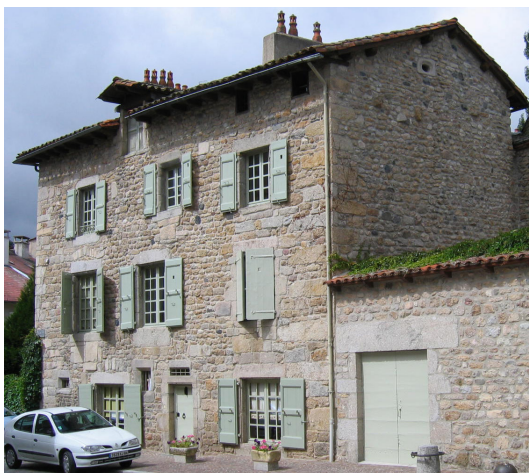
Exemple de façades ne nécessitant pas un enduit car les moellons ont été soigneusement choisis et montés.
